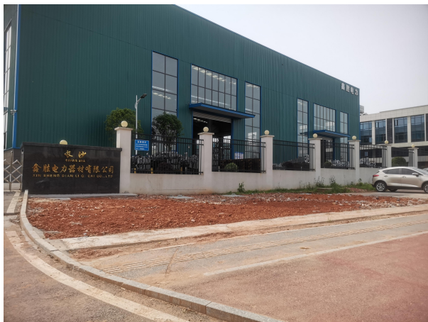
地埋式雨水收集池和事故应急池
