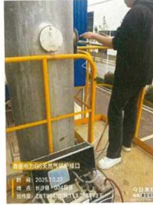
排气筒 (DA003) 出口G6 (采样日期: 2025-10-22)
