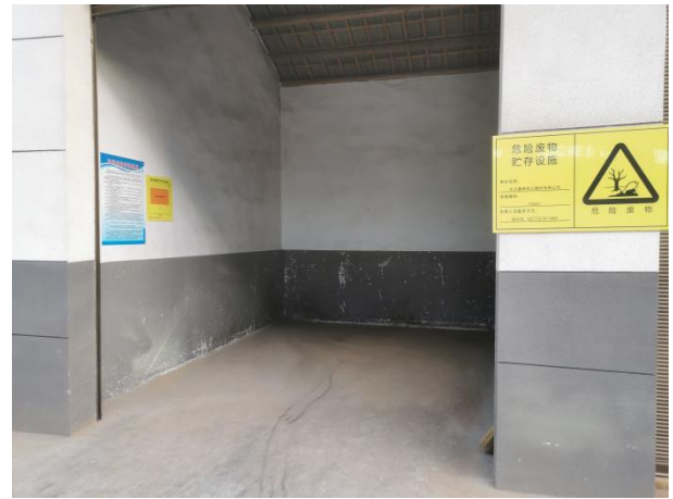
危险废物暂存间
