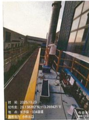
排气筒 (DA004) 出口G8 (采样日期: 2025-10-23)
