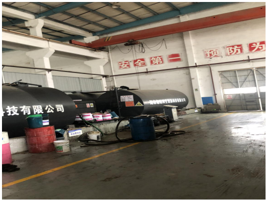
废油储罐围堰
