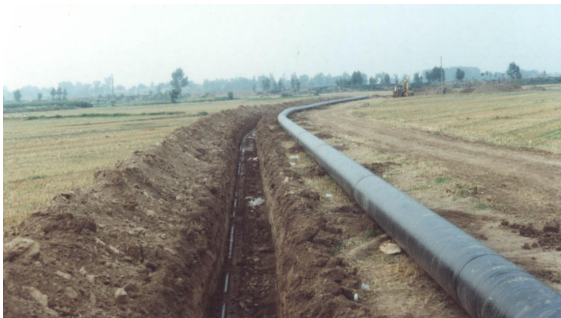
图 3-3 管沟开挖及布管类似实景图
