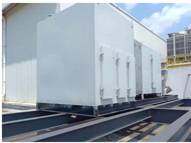
发泡废气活性炭吸附装置外部
