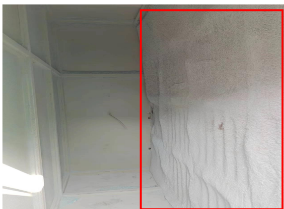
废气处理装置过滤棉
