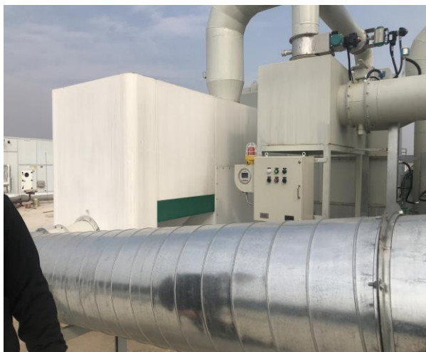
水性涂料车间废气处理设施
