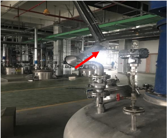
反应釜投料口集气装置
