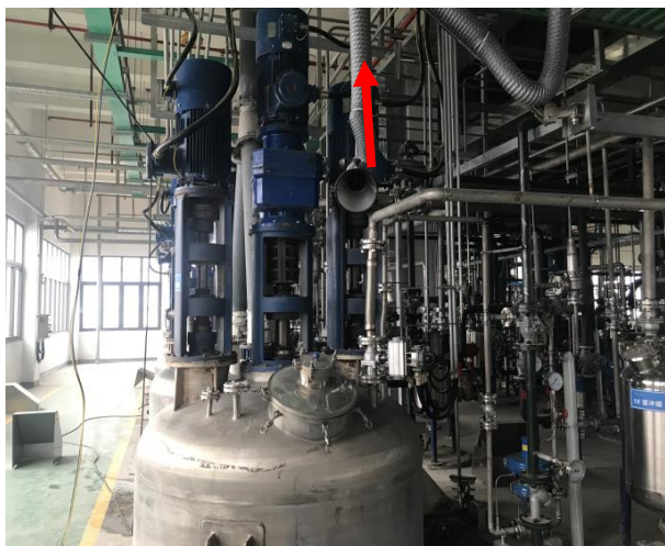
反应釜投料口集气装置
