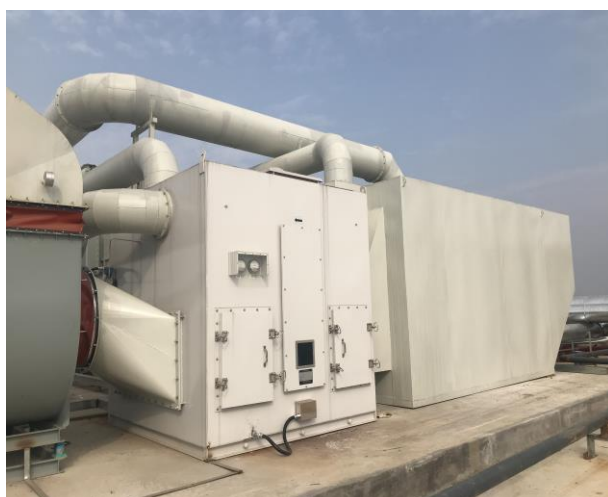
油性涂料车间废气处理设施
