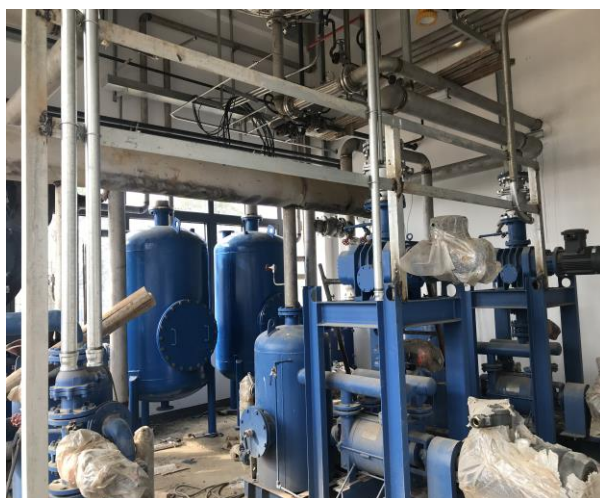
真空泵废气收集装置
