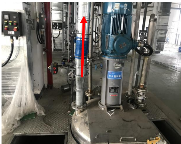
反应釜废气收集装置（放空管收集装置）
