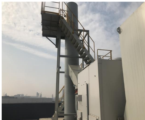
油性涂料车间废气处理设施及排气筒
