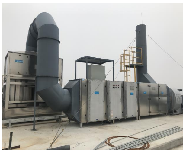
水性涂料车间废气处理设施
