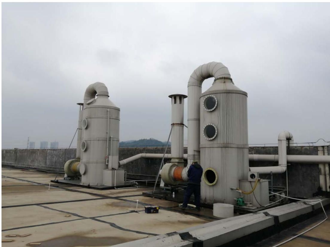
图 7.2-3 现有工程（一期工程）已建酸雾吸收塔现状图
