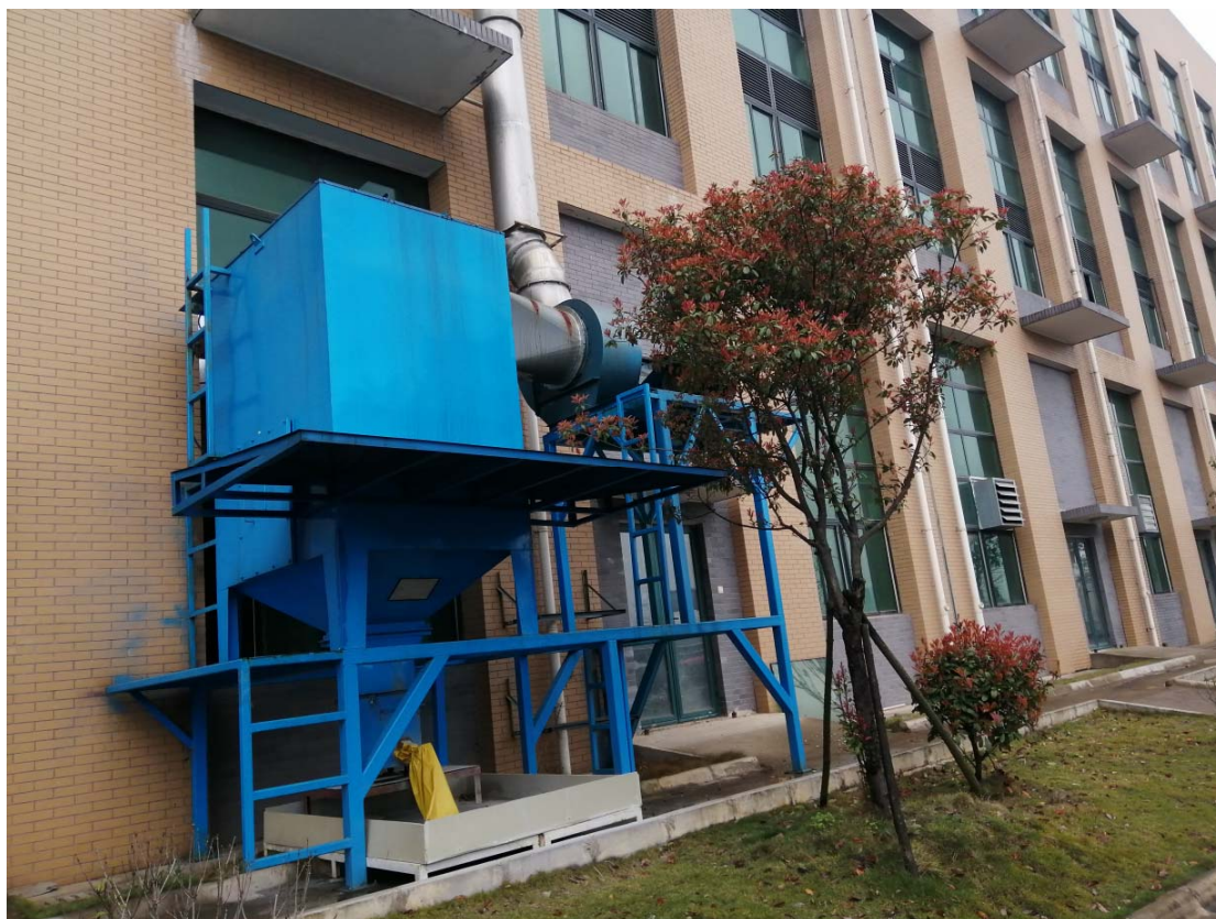
图 7.2-7 现有工程（一期工程）已建布袋除尘器现状图
