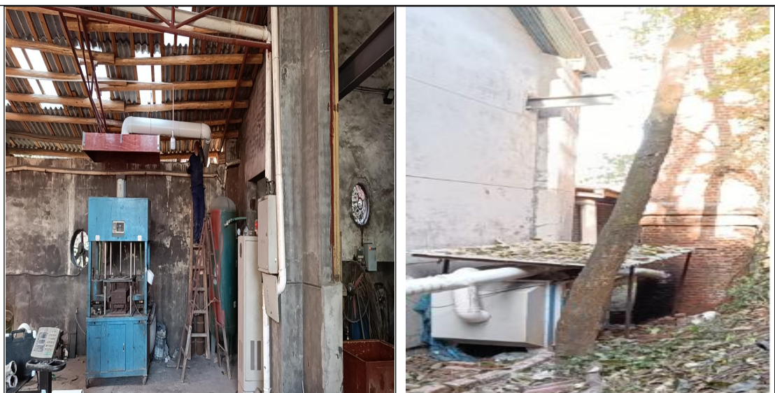
集气罩+UV 光解+活性炭吸附+排气筒装置
