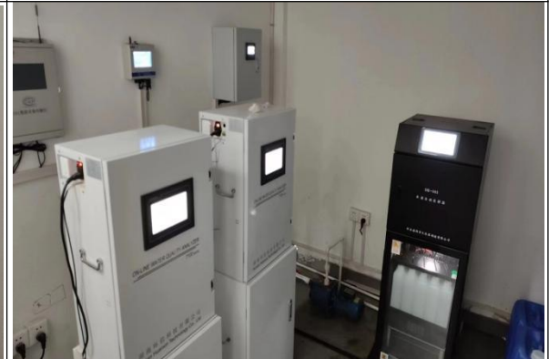
流量、PH 值、COD、氨氮在线监控系统
