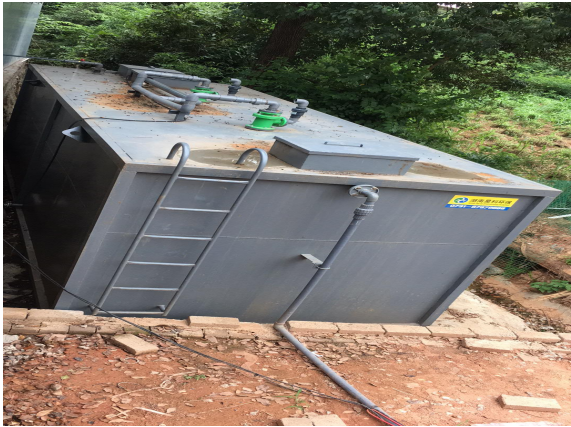
生活污水一体化处理设施（包括调节池、A 级反应池、O 级反应池和 MBR 池）
