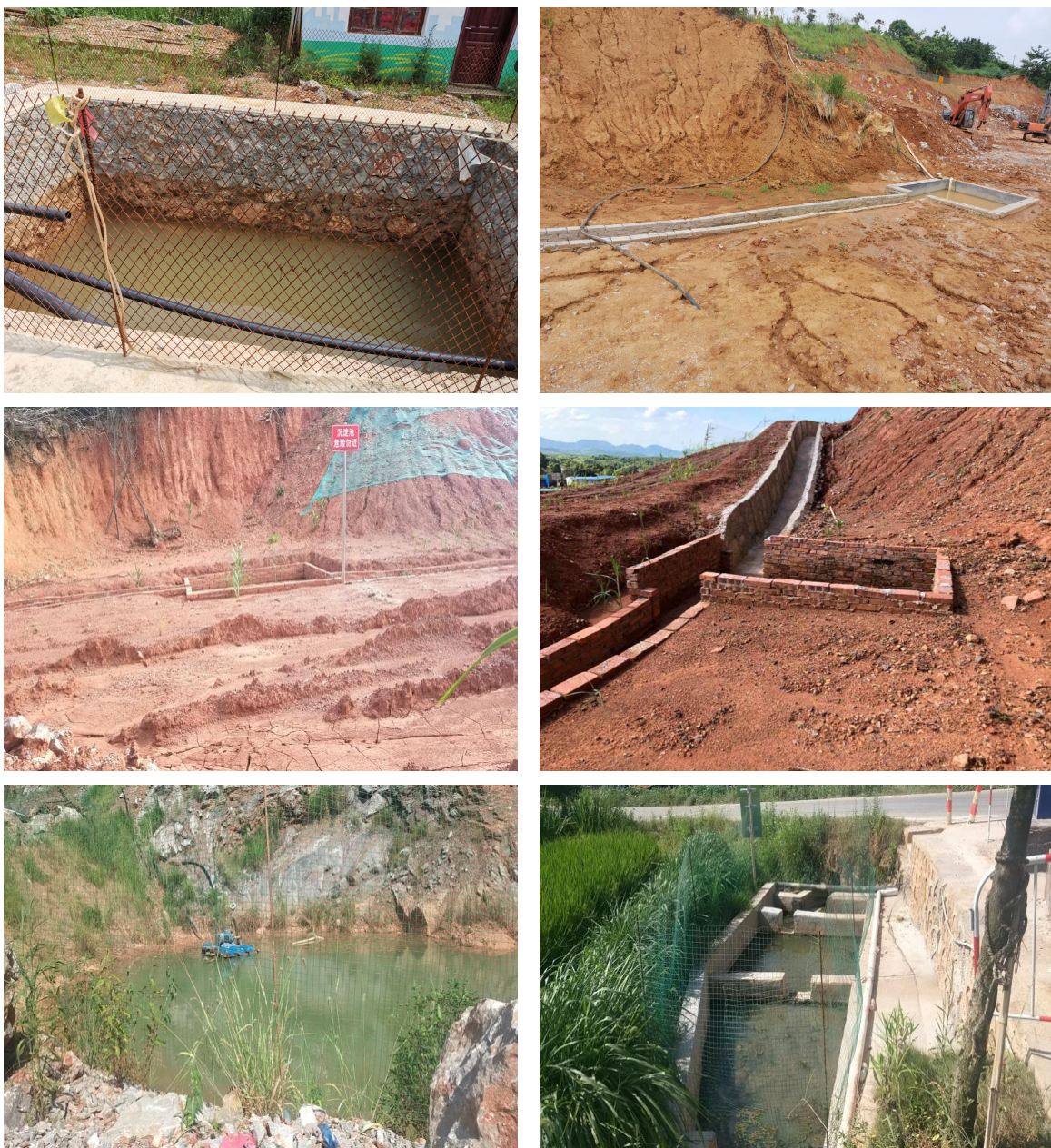
项目排水沟渠及雨水收集、沉淀池
