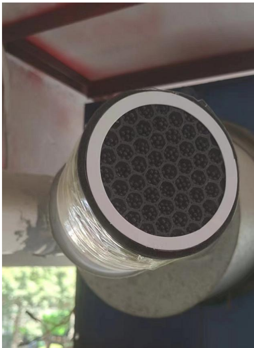
排气口已安装的活性炭吸附装置
