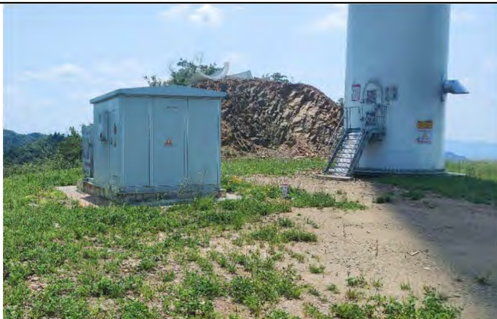
箱式变压器及基础
