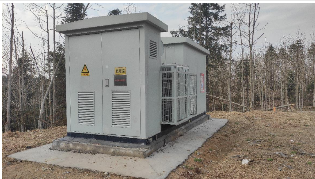
箱式变压器及基础
